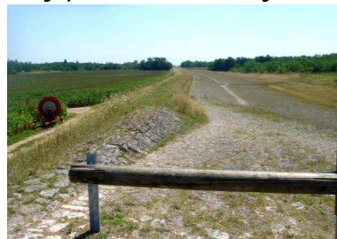
Photographie 20 : Le déversoir de Jargeau
