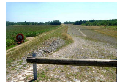
Photographie 5 : Le déversoir de Jargeau
