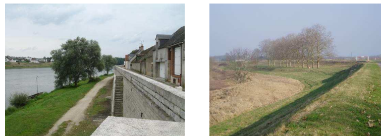
Photographie 19 : Ouvrages contre la montée de la Loire à Jargeau
