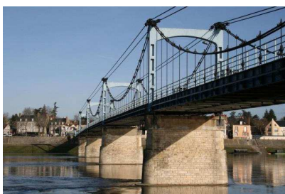
Pont suspendu restauré en 1994
