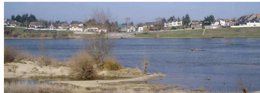
Photographie 40 : Le front bâti de Saint-Denis-de-l'Hôtel
