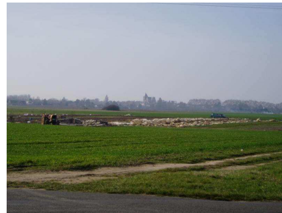
Photographie 33 : Vue lointaine sur l'église de Checy
