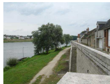
Photographie 6 : Ouvrages contre la montée de la Loire à Jargeau
